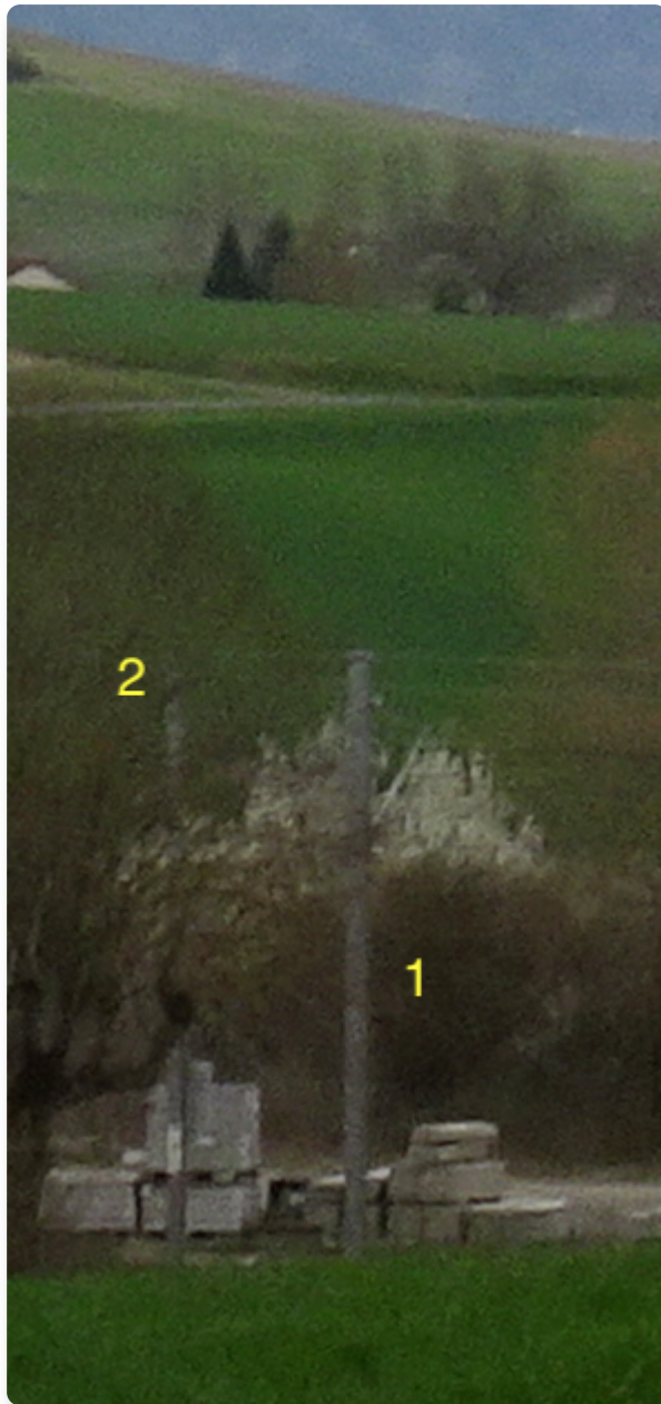
図4.13 : 観測ポイントから視線ラインを正確に合わせるための近くの目印の選択 (1 : 手前の柱 ; 2 : 線路の向こう側の柱)
